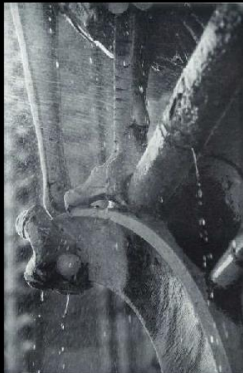
NOTRE DAME DE PARIS Lavage des parements à l'eau. Facings water washing. B. Vitry acmh
