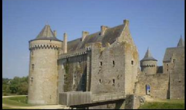
1990 TOITURE ARDOISES D. Lefèvre acmh SLATE ROOF
